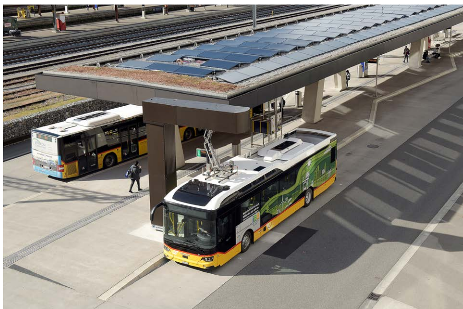
Das Postauto wird mittels eines sogenannten Pantografen von oben während seiner zwölfminütigen Standzeit mit Strom versorgt.
