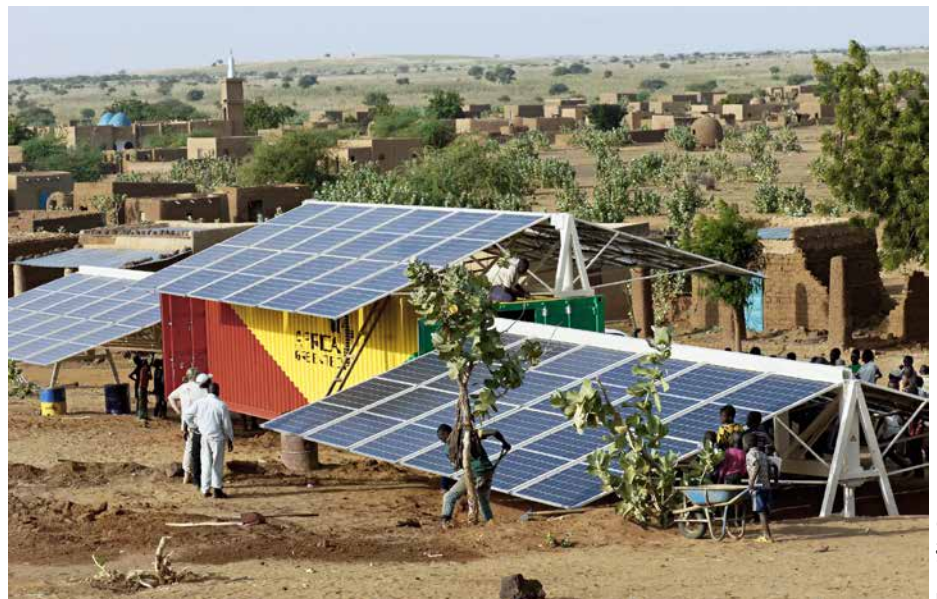
Eine Photovoltaik-Anlage mit Microgrid für ein Dorf in Westafrika. Im Container, dem sogenannten Solartainer, ist auch eine Lithium-Ionen-Batterie, eine Wasseraufbereitungsanlage und eine Wifi-Satelliten-Verbindung integriert.
