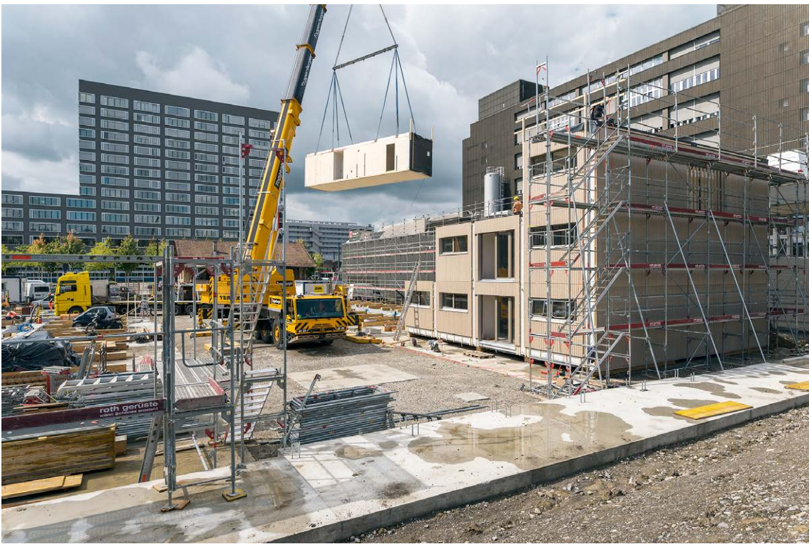
Aufbau des Holzmodulbaus «Wohnen am Vulkanplatz» im August 2018.
