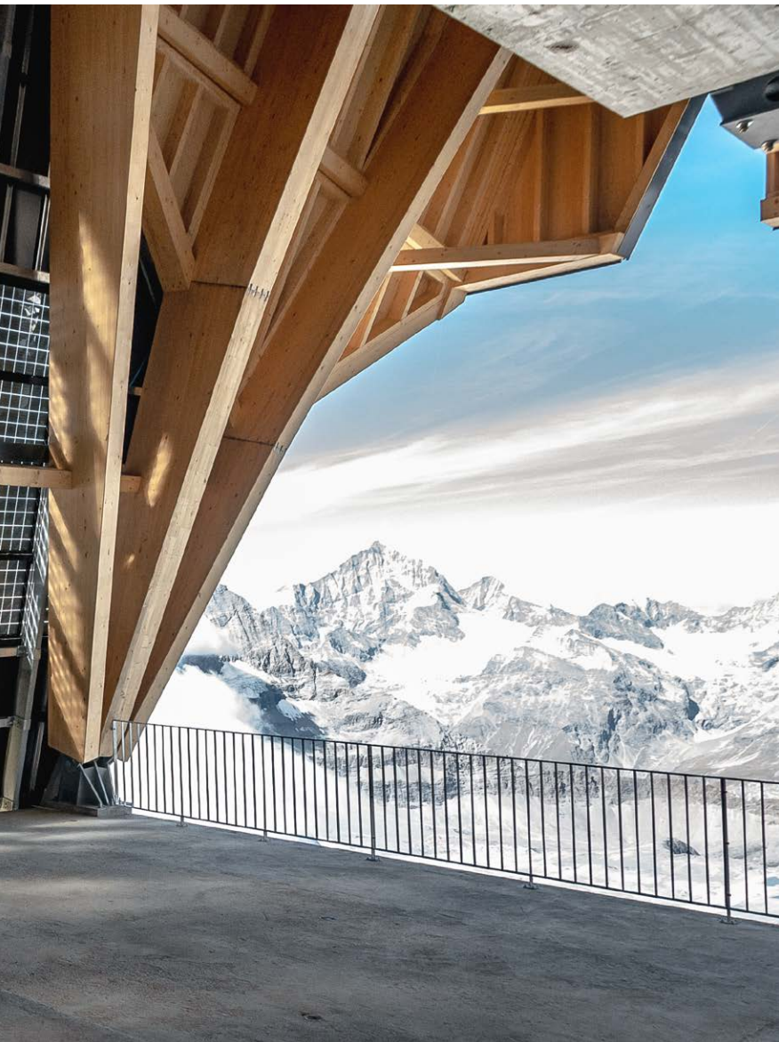
Bergstation Klein Matterhorn, Foto: Daniel Indermühle, Indermühle Baugenieure
