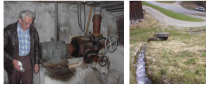
Augenschein im alten Wasserkraftwerk Seewis-Schmitten. Die Anlagen müssen gründlich renoviert und überholt werden (l). Blick auf die Wasserfassung des Kleinkraftwerks (r.).
