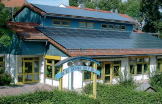
Platz für die Sonne: Auf dem Kindergarten Kunterbunt in Kempten sorgt die Sonne für Power
