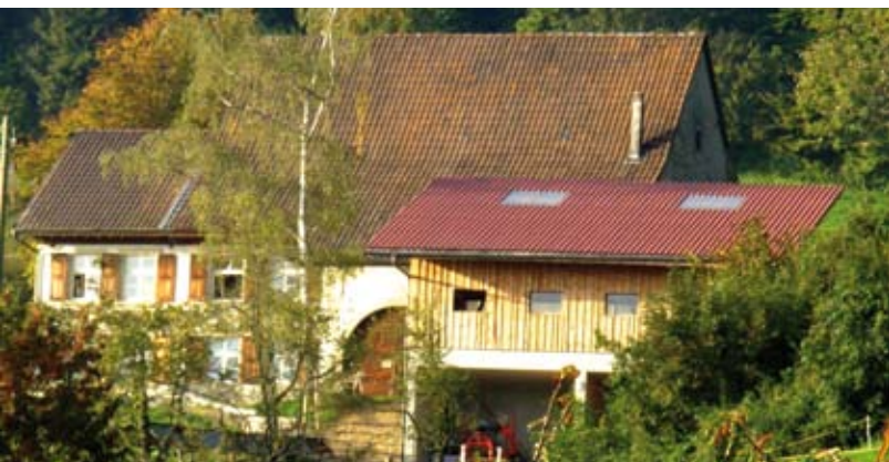
Das erste Sonnenkraftwerk im Gebiet der Elektra Sissach wird am Fuss der Sissacher Fluh gebaut.
