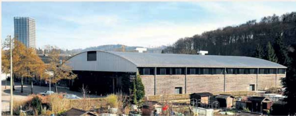
Geht es nach den Plänen des Vereins «Solarspar», soll auf der Eulachhalle eine Photovoltaikanlage eingerichtet werden, die ab dem kommenden Sommer Strom für 38 Einfamilienhäuser liefert. Bild: Marc Dehnbach
