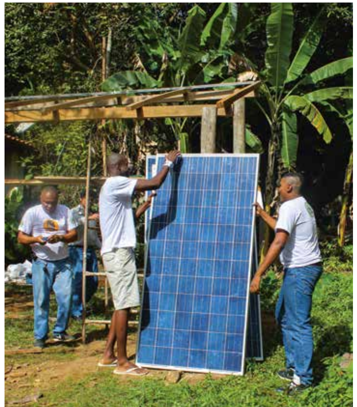
In Quilombo do Grotão wird die erste Solaranlage im traditionellen Dorf montiert. Weitere 13 sollen folgen.
