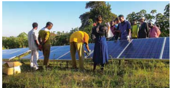
Weitab von jeder Erschliessung erhalten Schulen und Spitäler elektrischen Strom.
