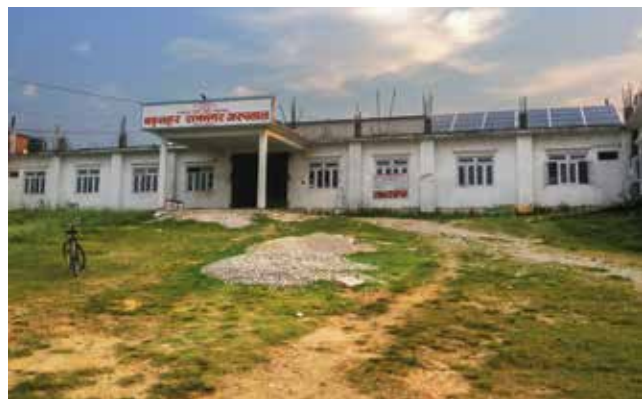
Im Spital sorgt die Sonne für eine zuverlässige Stromversorgung.
