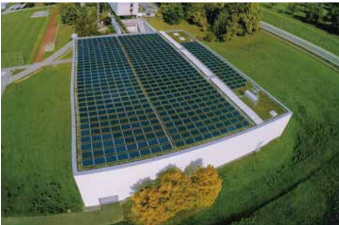
Luzern Kantonsschule Baldegg Seetal, Turnhalle
