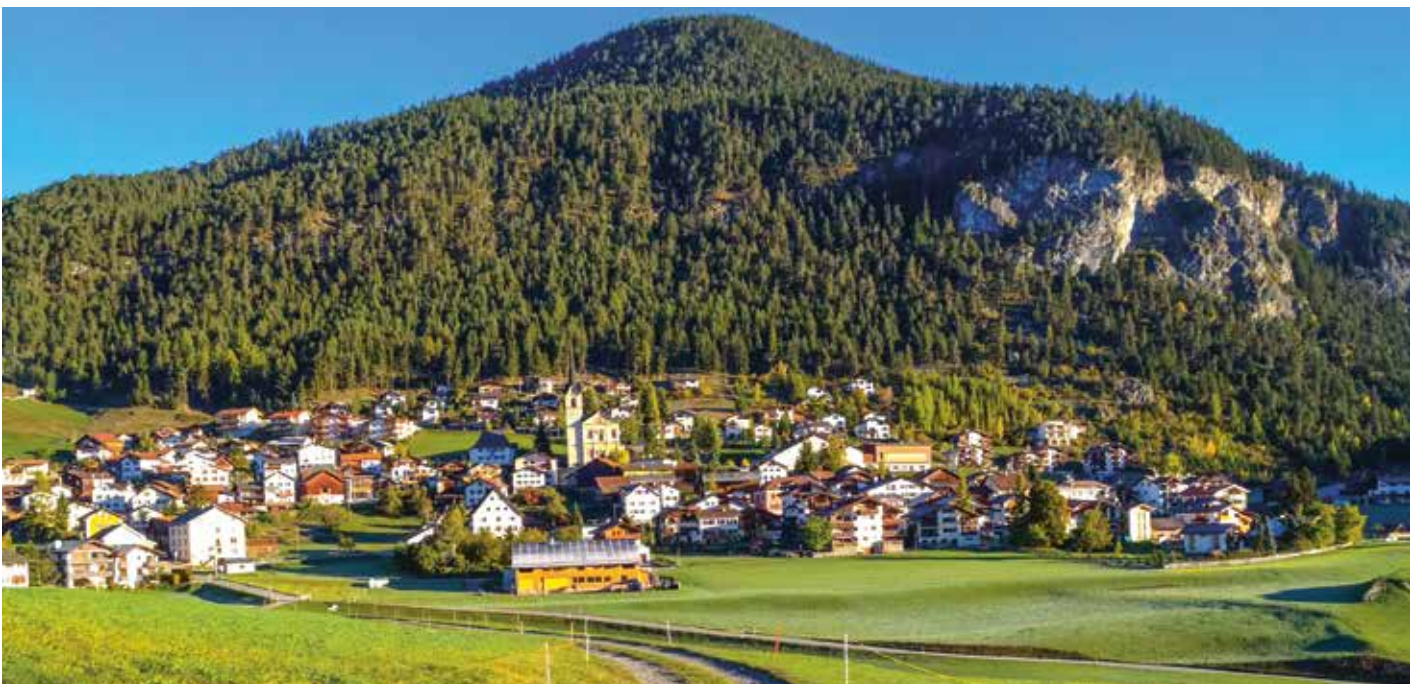
In Alvaneu machen Bauern beste Erfahrungen mit Solarenergie. Vorne, in der Mitte, steht der Stall von Paulo Negrini mit Solardach.
