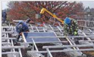
Montage der Solarpar und Solarzellen. Heute auf der Dach der Sekundarschule.
