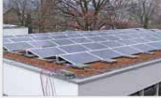
Fertiggestellte und montierte die Fotovoltaik-Anlage auf der Dach der Sekundarschule.
