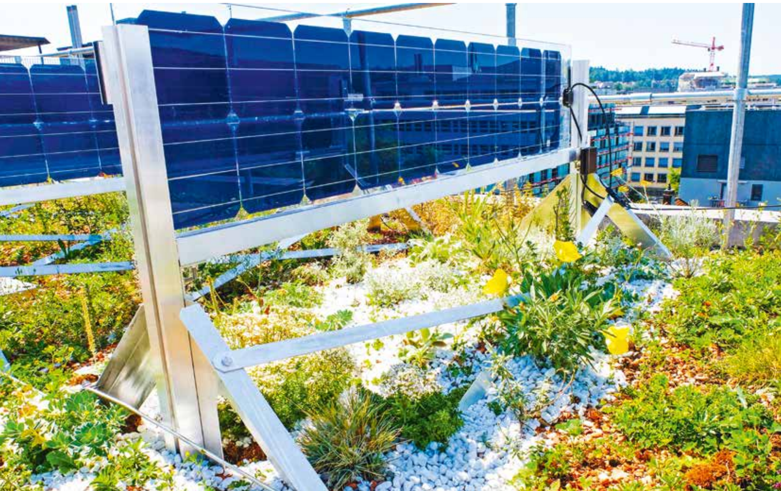
Solarspar-Forschungsdach: Niedrig wachsende Nachtkerzen blühen unter den neuen, vertikal aufgeständerten, beidseits beschienenen 20er Modulen.
