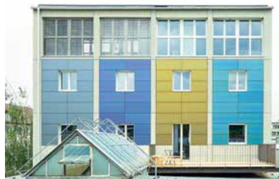
Das „Kohlesilo“ in Basel ist mit mehrfarbig verglasten Solarzellen ausgestattet. (Foto © Solarpreis)
