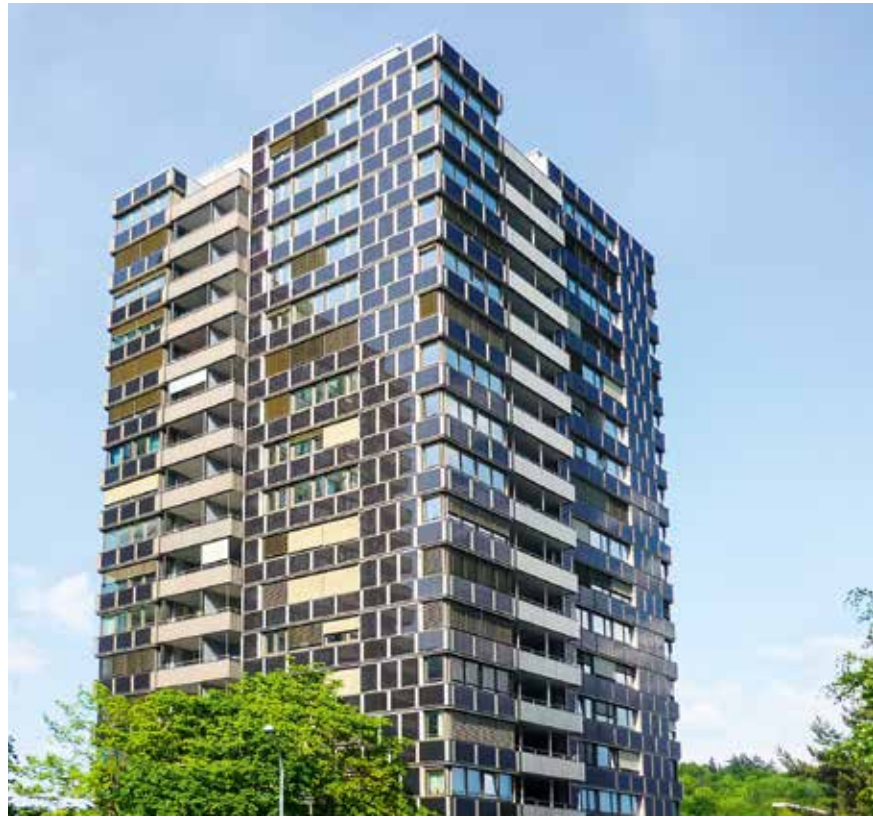
Das Hochhaus „Sihlweidstrasse 1“ in Zürich erhielt 2011 die damals grösste umlaufende PV-Dünnschichtfassade der Welt. (Foto © Sharp Electronics)
