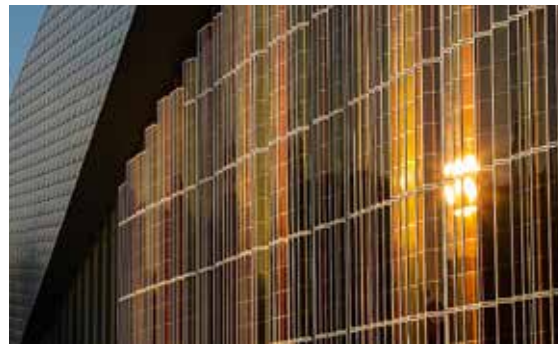
Das „Kohlesilo“ in Basel ist mit mehrfarbig verglasten Solarzellen ausgestattet. (Foto © Solarpreis)
