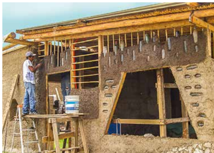
Ganz aus Naturmaterialien gebaut – das neue Gebäude der Firma „La Sazon del Sol“.
