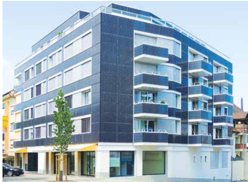
2013 gewann das Architekturbüro Viridén+Partner für den Umbau dieses Mehrfamilienhauses in Romanshorn den Europäischen Solarpreis. (Foto © Solarpreis)
